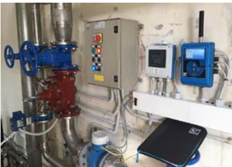
Możliwość podłączenia sterownika CLA-VAL D-22 bezpośrednio do urządzeń zainstalowanych na zaworze
